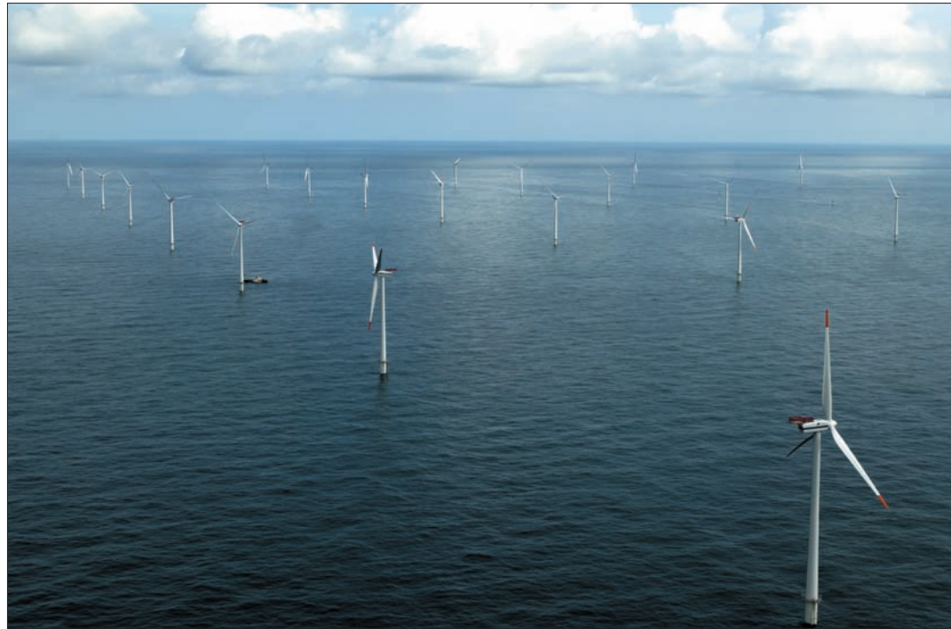
Aus Energieüberschüssen, die z. B. bei Windparks (im Bild Horns Rev) oder Wasserkraftwerken anfallen, kann zzt. schon preisgünstig Wasserstoff erzeugt werden
